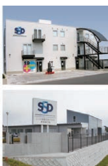
新横浜工場 新宮城工場
